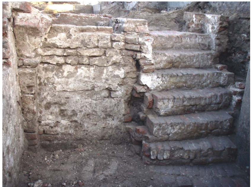
Afbeelding 56: ruimte A richting noorden. Onder de grondboog is de helft van de ring van de brouwoven zichtbaar die in de kloostertijd gebruikt werd als beerput.
