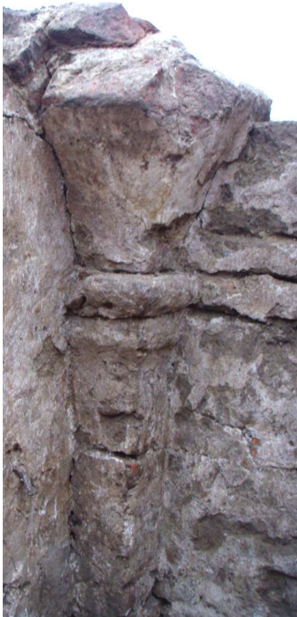
Afbeelding 57 en 58: links de geprofileerde hoekpilaster in ruimte B waarop het kruisgewelf rustte en boven diezelfde pilaster in relatie tot de keldertrap. Richting noorden gefotografeerd.
