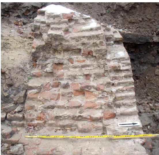
Afbeelding 35: doorsnede door het westelijke stuk stadsmuur. Hier is goed te zien dat de muur aan de veldzijde (rechts) een nieuwe schil heeft.
