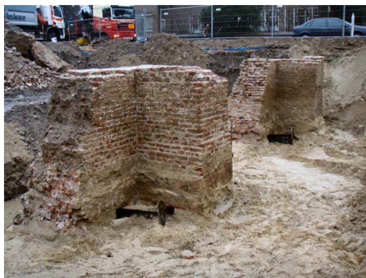
Afbeelding 37 (boven): aanzicht van de spitsboogfunderingen (steunberen) vlak voor transport.
