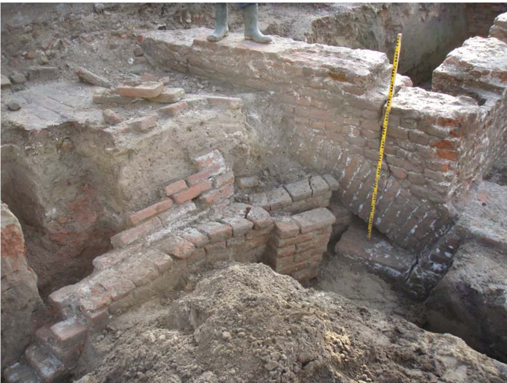
Afbeelding 45: de brouwoven in relatie tot de spaarboog van het klooster. Hier is ook goed te zien dat het om een compleet gebouwtje gaat: boven de stookgang bevond zich een tongewelf.
