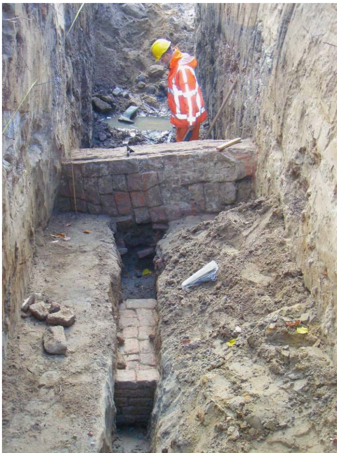
Afbeelding 41: de veertiende-eeuwse keermuur in profielsleuf 1. Op de voorgrond de onderkant van de muur en op de achtergrond het omgevallen stuk muurwerk.
