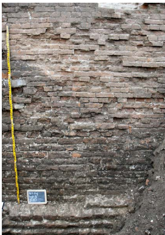
Afbeelding 36: het oostelijke deel van de stadsmuur. Boven de muur vanaf de veldzijde, met daaromheen zware betonnen poeren van het Coberco-gebouw. Onderin de schil van 16 e -eeuwse stenen, in de middenzone 13 e -eeuwse stenen en bovenin post-middeleeuwse herstellingen.
